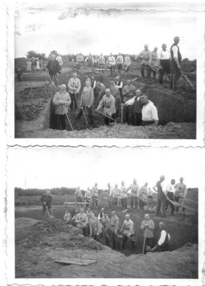
2 Bilder von den Ausschachtungsarbeiten
